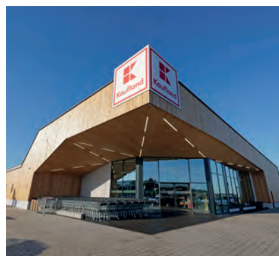
Die Kaufland-Filiale in Bratislava besteht zu drei Vierteln aus Holz.
